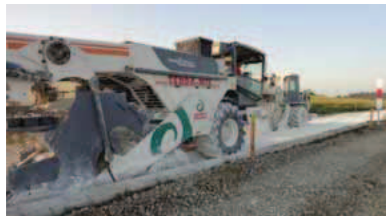
Stabilisierung einer Dammschüttung
