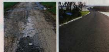
Asphaltschichten mit Schotterunterbau (1), abgestuftes Gemisch aus Asphaltgranulat und Schotter (2) mit Tragschichtbinder (3) und Wasser (4) vermengt, ergeben eine hochwertige Tragschicht (5).
